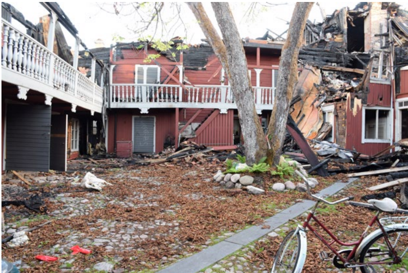
Figur 30: Gårdsrommet før rivingsarbeidene startet. For å beskytte stenleggingen ble det lagt markduk og et relativt tykt bærelag av grus. Foto: Jönköpings Läns Museum
