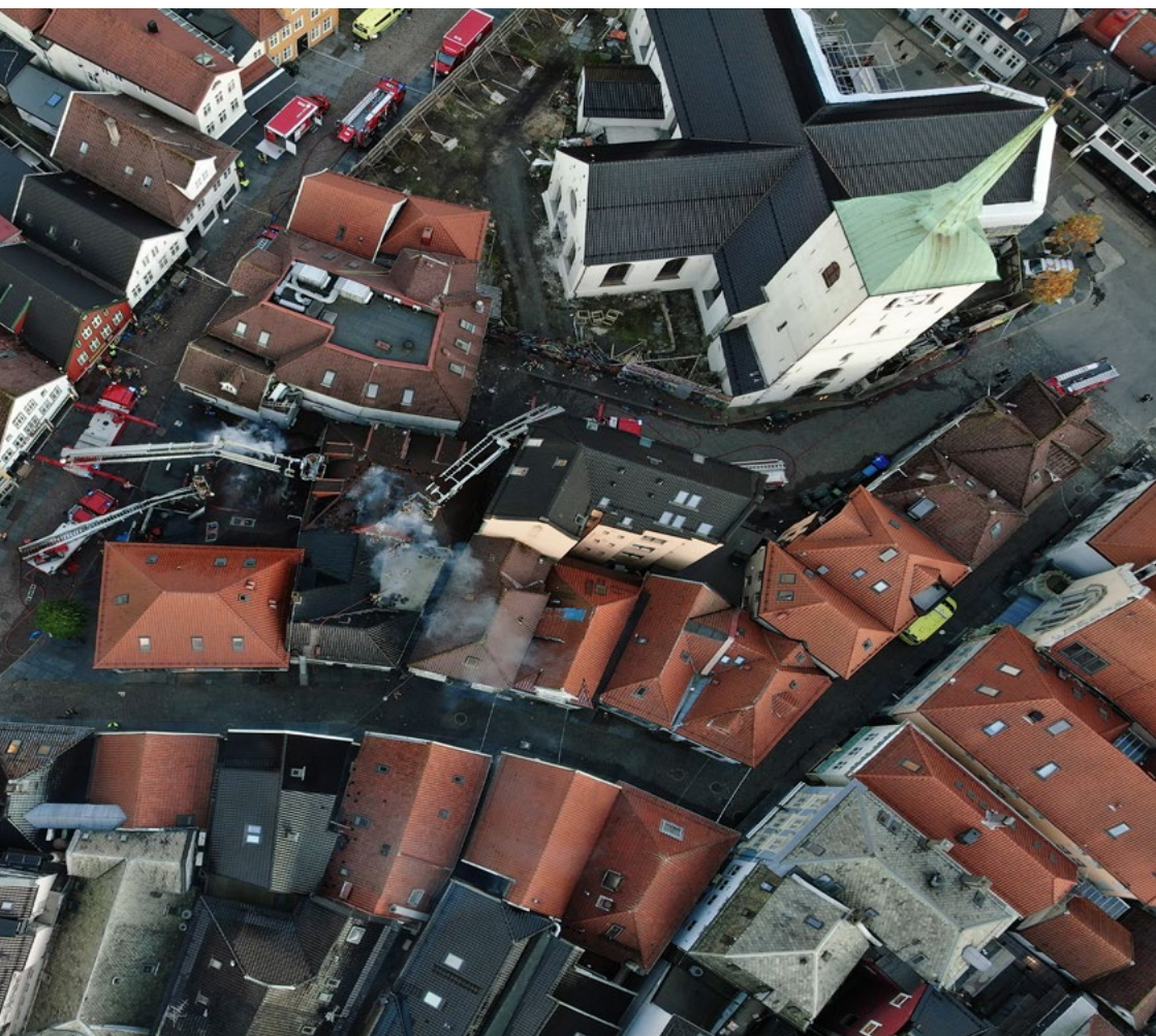
Figur 12: Dronefoto under brannen i Bergen sentrum oktober 2023. Foto: Drone, Bergen brannvesen.
