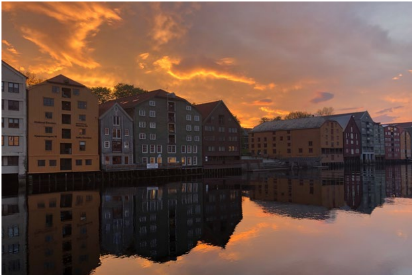
Figur 22: Detalj fra bryggerekka langs Nidelva i Trondheim. Foto: NIKU.
