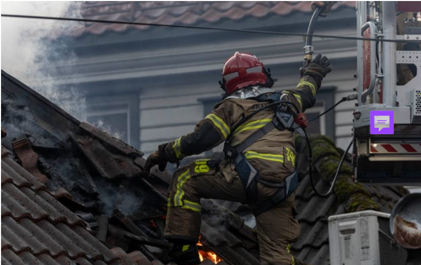
Figur 3: Slokkearbeidet i Bergen sentrum, oktober 2023. Foto: Bergen Brannvesen.
