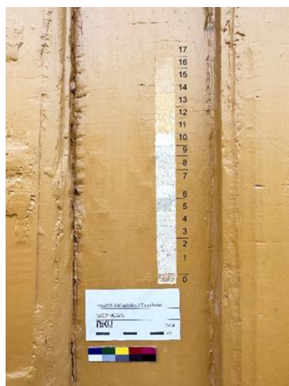
Figur 2. Fargetrapp nordvegg 2. etasje.
