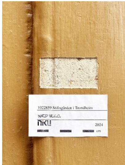
Figur 3. Avdekning 1. etasje av eldste fargelag umiddelbart etter avdekning 8.oktober 2024. Foto Christina Süss NIKU
