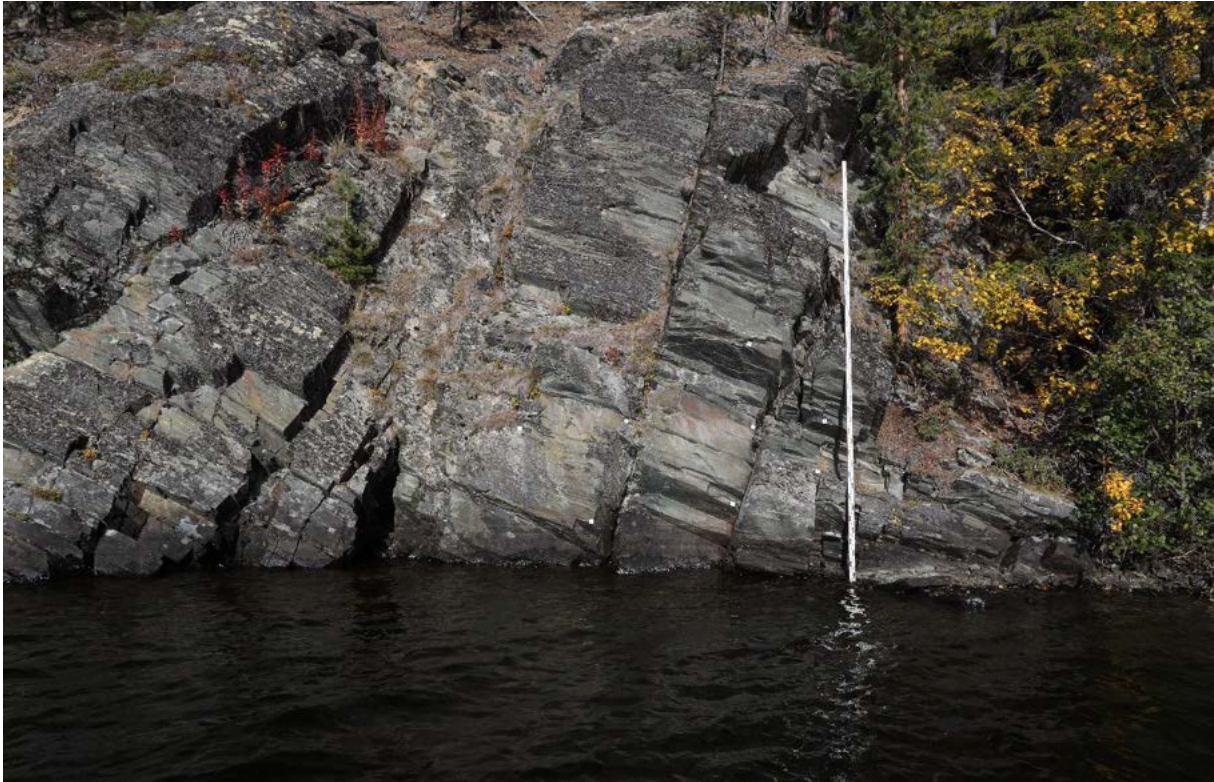
Figur 24. Ein kan tydeleg sjå merkene i berget under figurane på Felt 1 etter variasjonen i vasstanden i Espedalsvatnet der dei opptre som horisontale linjer den 24 september 2019. Stadiet i bildet måler 4 m i lengde. Foto:184A6723.JPG. Foto: Jan Magne Gjerde.
