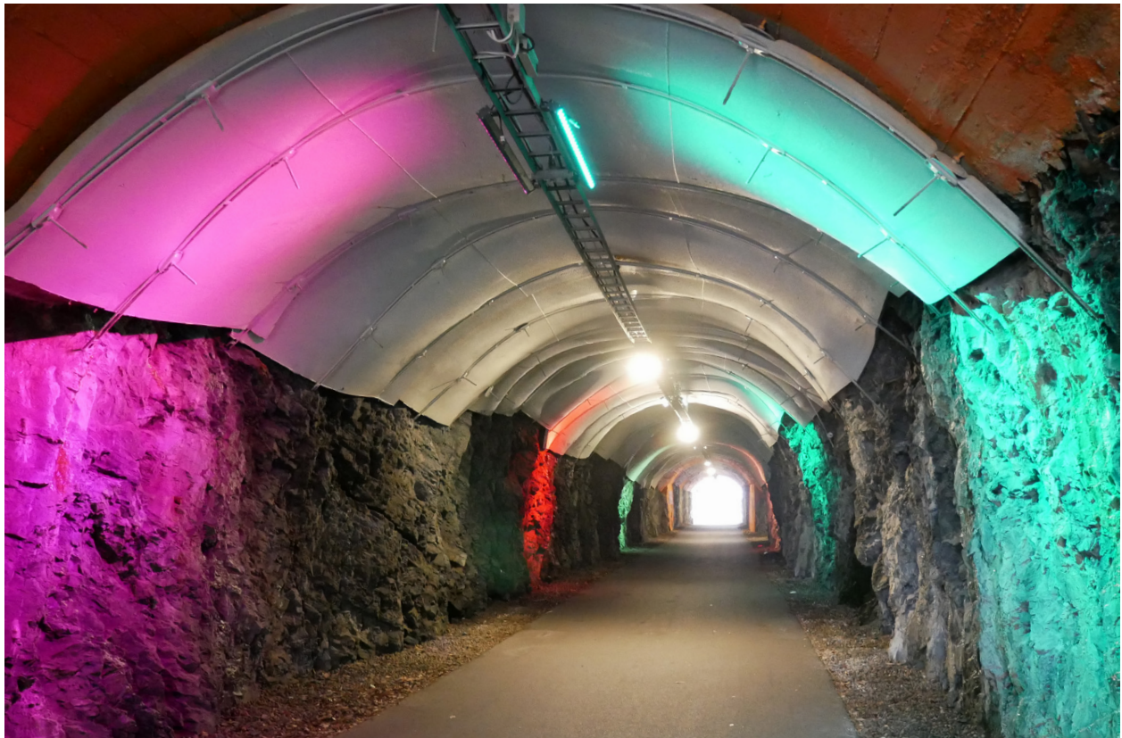
Gjenbruk av produksjonstuneller som en del av gang- og sykkelnettet på Klosterøya. Foto: Høst 2021, O.H. Hagen
