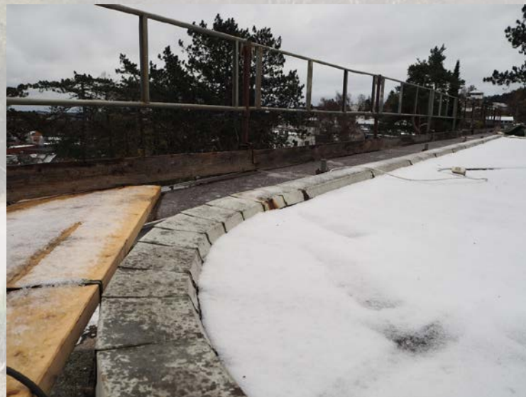
Flate tak og korroderende beslag
