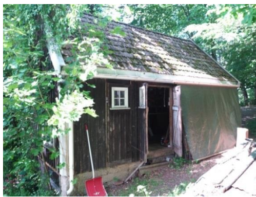
Uthus for dyrehold er oppført på samme tid som bolighuset og har godt bevarte bygningsdetaljer. Foto: NIKU 2017.
