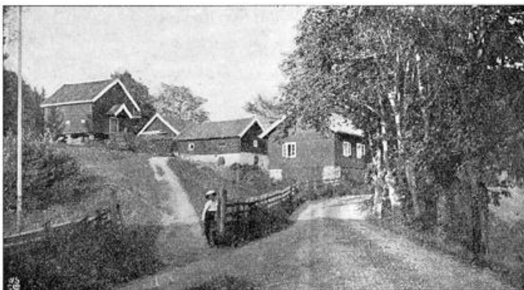
De gamle uthusene på Øvre Sem sett fra adkomsten til gården i vest. Foto 1914 (Nilssen 1916), kilde: Kyhn.
