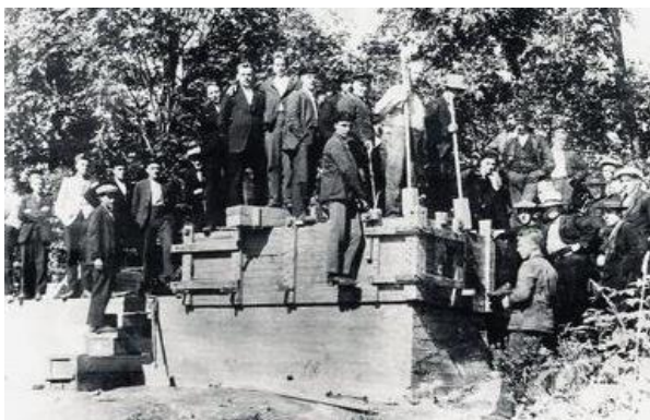
Demonstrasjon av stampeteknikk under oppføring av jordhus på Sem. Kilde: Kile.
