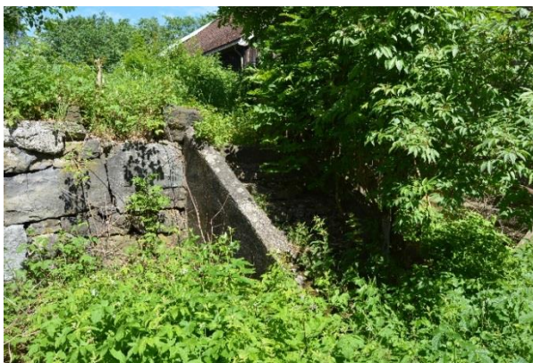
Forstøtningsmur og trapp ved driftsbygning. Foto: Bjørn Anders Fredriksen, 2017.
