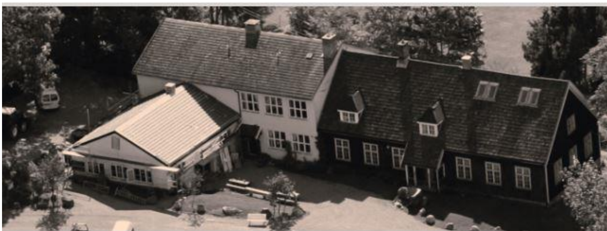
Driftsbygningen som i dag disponeres av organisasjonen NaKuHel består av tre sammenhengende bygninger oppført i henholdsvis 1918, 1939 og 1952-55. Verkstedbygningen/ «Vevstua» fra 1918 til høyre. Foto: Historisk innblikk Sem, www.nakuhel.no
