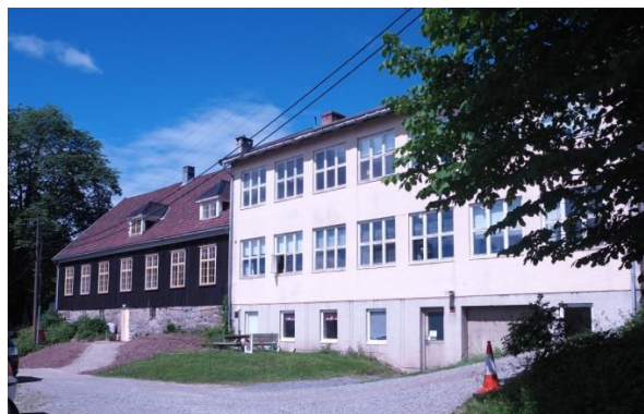
Mekanisk verksted sett i sammenheng med Verkstedbygningen, fasade mot syd. Foto: NIKU 2017.
