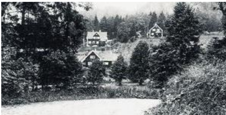
Lærerbolig 1 og 2, sett fra Semsveien, i forgrunnen ligger Småbruk 1. Foto:Kile.
