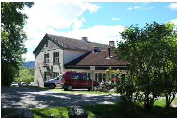
Mekanisk verksted sett i sammenheng med smie, fasade øst. Foto: NIKU 2017.
