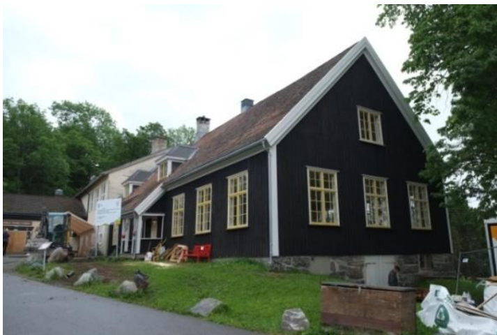
Den fredete «vevstua» (verkstedbygningen) blir istandsatt etter antikvariske prinsipper sommeren 2017. Foto: NIKU.
