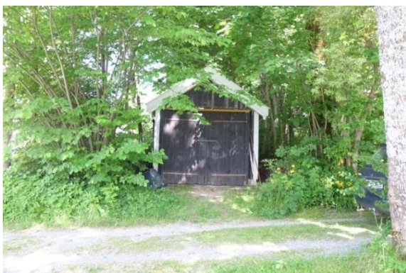
Garasje, oppført ca. 1950. Foto: NIKU 2017.
