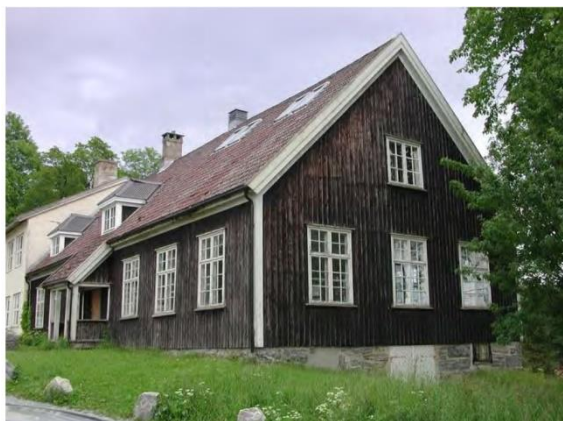
«Vevstua» /verkstedbygningen, sett fra vest. Foto: Bjørn Anders Fredriksen, 2011. Opphavsrett: NMBU.
