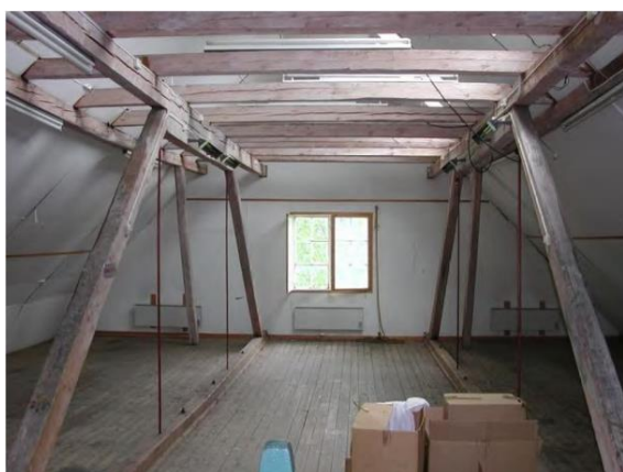
Loft i verkstedbygningen. Fotoet viser hvordan dekket over 1.etasje er hengt opp i takkonstruksjonen med stålstag. Foto: Bjørn Anders Fredriksen, 2011. Opphavsrett: NMBU.
