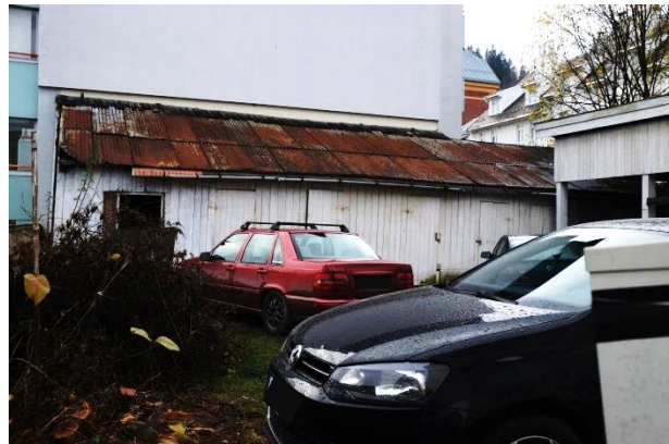
Uthuset har enkelt bølgeblekktak. Til høyre ses nyere uthus/carport.
