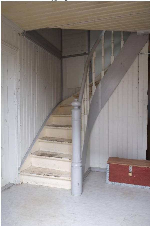
Trappeoppgang 1.etasje med eldre paneler og dører.
