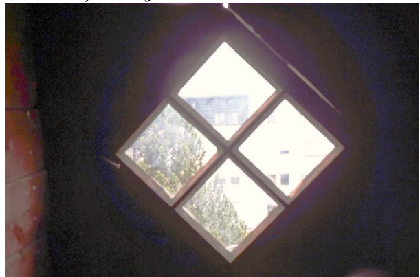
Loftsvindu i kott på loft, sett innenfra.
