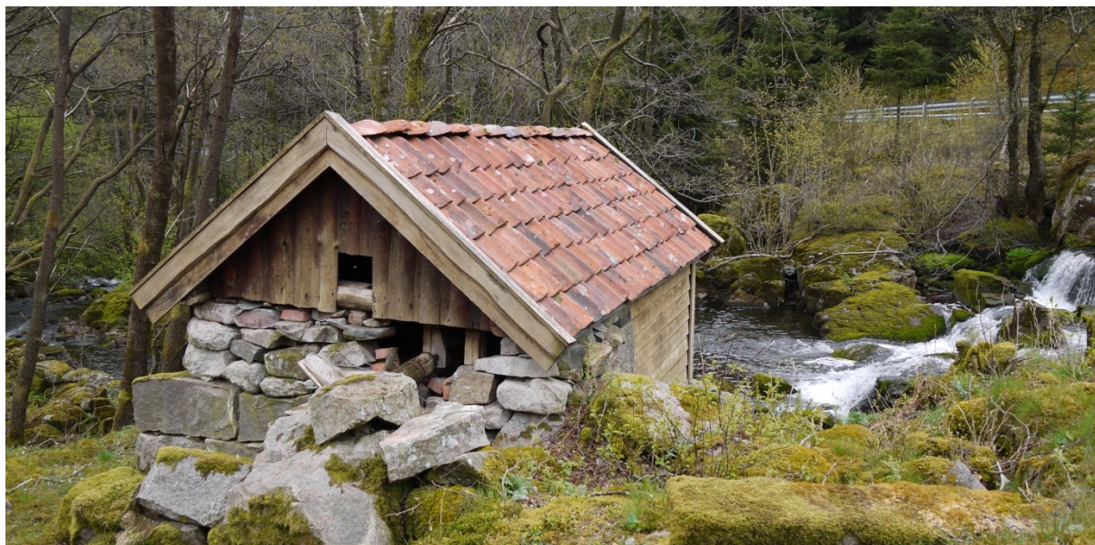
11020031108: Bekkekvern og -sag i tilknytning til gårdsbruk er spesielt utsatte bygninger, på grunn av funksjonstømming. Dette kvernhuset i Sandnes er fint istandsatt. Foto: J. Sognnæs/NIKU 2012
