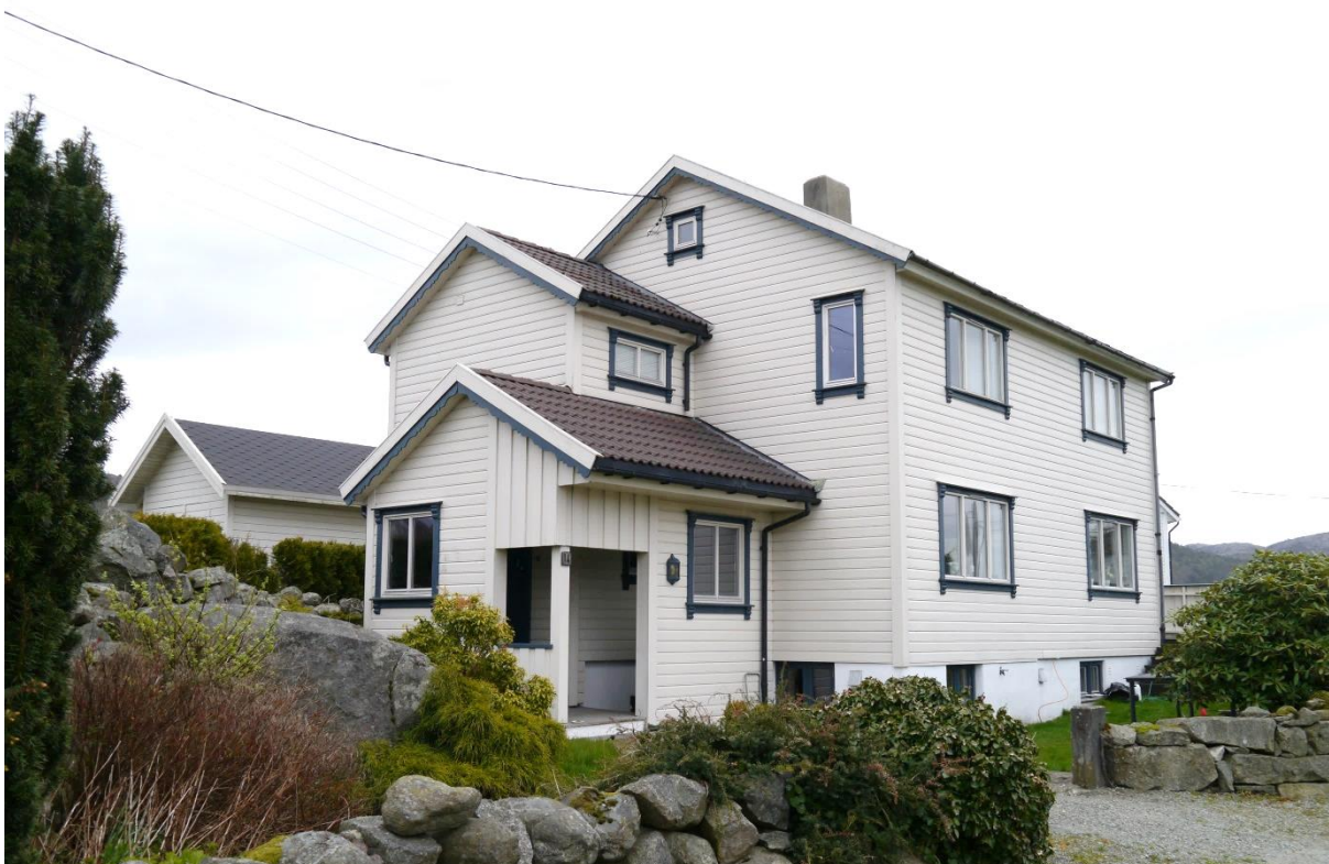
11020029021: Et nytt inngangsparti er en vanlig volumendring, slik som tilbygget på dette bolighuset i Sandnes. Av de ulike bygningstypene er det våningshusene og bolighusene som har flest volumendringer. Undersøkelsen viser samtidig at tilstanden for våningshus/bolighus er bedre enn totalgjennomsnittet (6 % truede og 2 % sterkt truede mot 10 % og 4 %). Foto: F. Carniel/NIKU 2012
