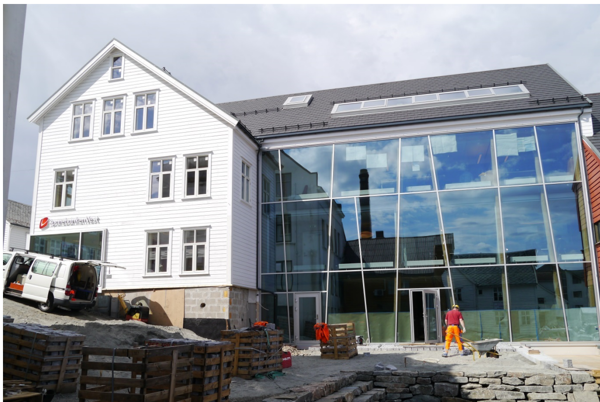
14010301010: Endringer som aktivt er påført bygningen registreres som enten A-endring, B-endring eller C-endring. 3 % av de gjenstående SEFRAK-bygningene i de 18 utvalgte kommunene har fått større volumendringer (A-endring) i årene etter den opprinnelige SEFRAK-registreringen (1975-1995), slik som denne bygningen i Strandgata i Florø. Foto: Å. Dammann/NIKU 2013
