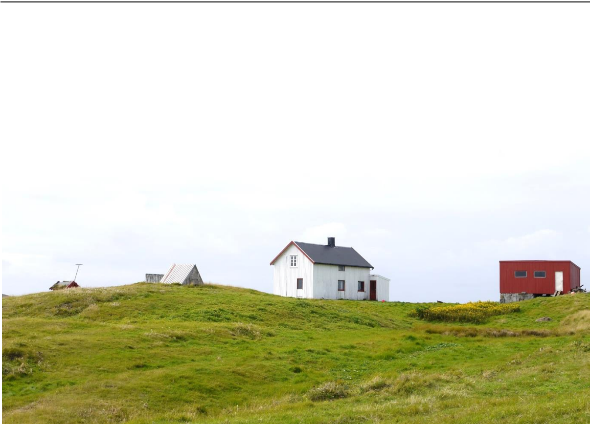
18150110098: Prosentvis tap av SEFRAK-bygninger har vært noe lavere i spredtbygde områder enn i tettbygde i alle omdrev av kontrollregistreringen, mens andelen truete/sterkt truete SEFRAK-bygninger er høyest i spredtbygde områder. Hysvær i Vega kommune. Foto: Å. Dammann/NIKU 2013
